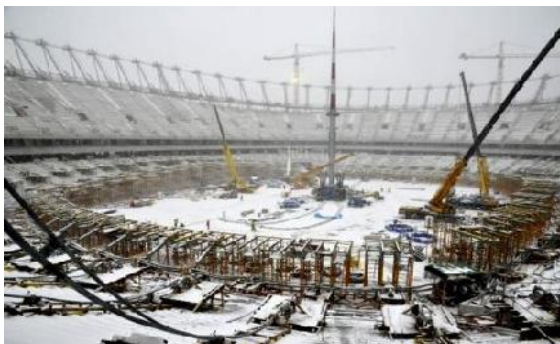
شکل ۷۴. کارگران و پرسنل عمرانی نیز در هنگام ساخت و اجرای پروژه در معرض انواع آلودگی‌ها هستند.
