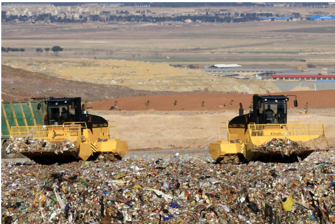
شکل (۲۶): عملیات دفع بهداشتی پسماند نیازمند به‌کارگیری اصول مهندسی، صرف هزینه و رعایت ملاحظات بهداشتی است.
